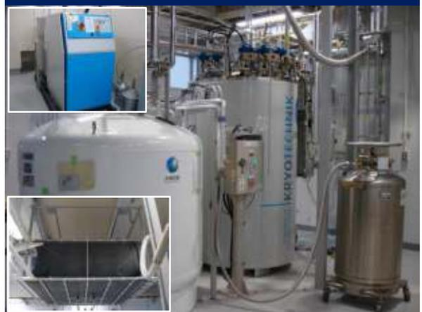
ヘリウムガス(気体)を圧縮冷却して液化し、液体ヘリウムとする設備です。ヘリウムは輸入に依存する稀少資源で左のNMR装置の冷媒としても使用されロス(ヘリウムガス)を回収して本設備により リサイクル利用ができます。
